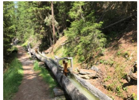
Vorbildlich ausgeführte Instandstellungsarbeiten (Foto: K. Liechti)
